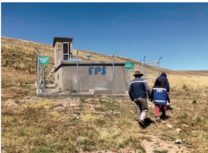
Instalação de distribuição de água potável em Waldo Ballivián, na Bolívia
