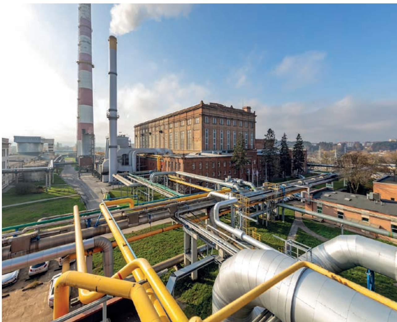
Lituanie : soutien de la BEI en faveur d'un chauffage urbain plus efficace à Vilnius.
