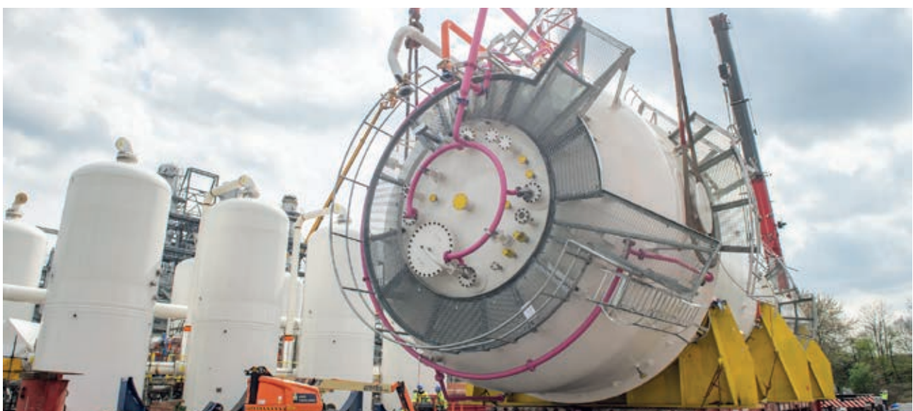
Opération de levage de bioréacteurs destinés à une production d'acier neutre en carbone dans l'aciérie Steelanol d'ArcelorMittal Belgium à Gand.
