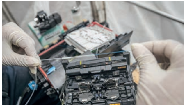
Ausbau des Open-Access-Glasfasernetzes von enet in Irland
